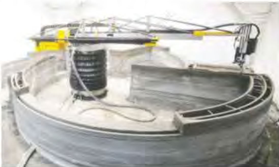
Mesin printer 3D pencetak rumah milik Apis Cor. (Sumber: digitaltrends.com)
